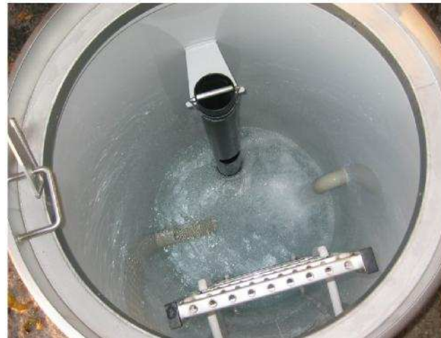
Foto 3: esempio nuova camera prefabbricata (in polipropilene PP)
