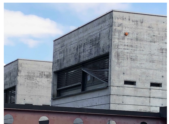
Immagine 6 - primo piano - facciata nord
